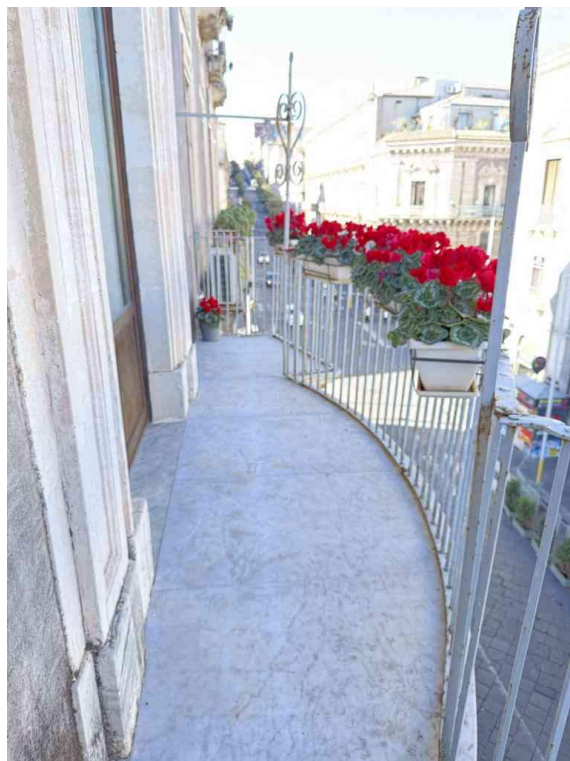
Foto n.17 Vista del balcone su via Antonino di Sangiuliano.
